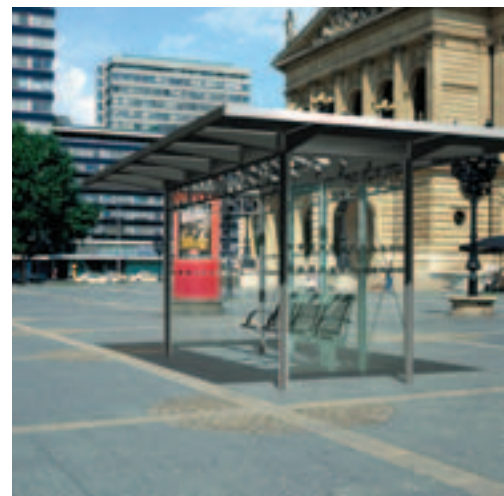
Eine Wartehalle mit Sitzmöbeln und auskragendem Dachkörper.
