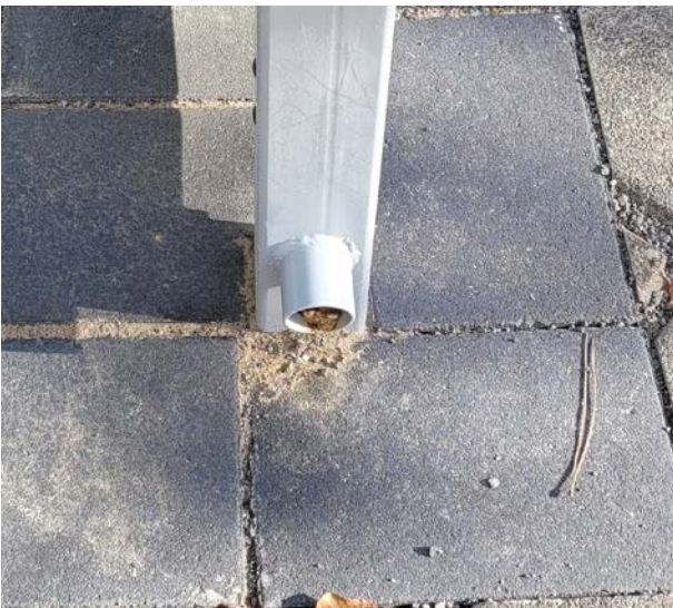
Wasserauslass der Regenrinne mittels Speier über OKF
