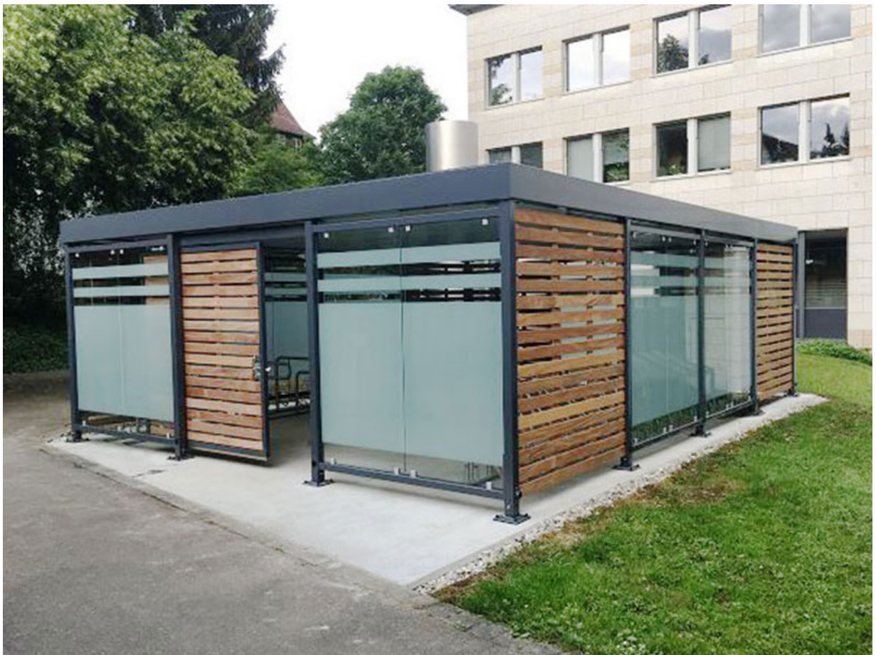
Fahrradüberdachung PROTECT mit geöffneter Zugangstür
