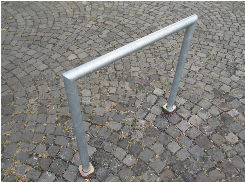
Anlehnbügel U aus Rundrohr in Bodenhülse
