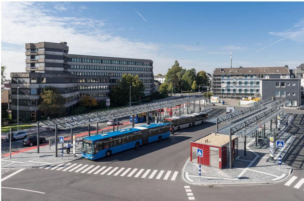
ZOB Velbert mit doppelzeiliger Überdachung System O freitragend mit Gitterträgern
