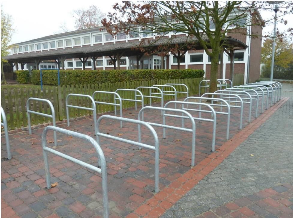
Fahrradbügel U mit Knieholm einbetoniert
