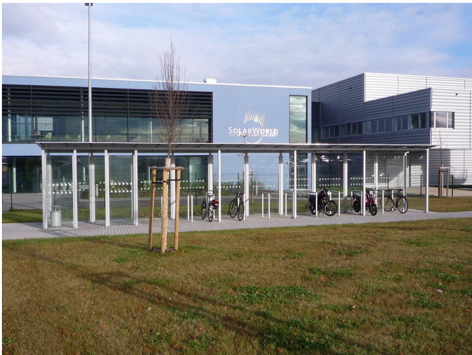
Fahrradabstellanlage RASTER 22 in Kombination mit Raucherunterstand einzeilig in Freiberg
