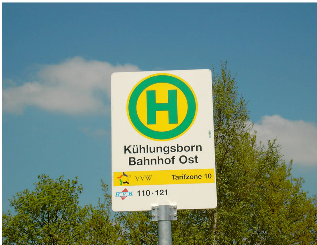
Kompaktschild ST-5 mittig auf Mast befestigt
