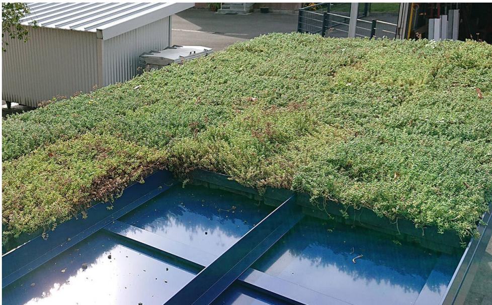
Detail der Dachkassetten zur Dachbegrünung der Wartehalle A-G
