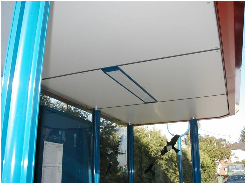
Wartehalle System TD Detail Unterdecke mit Beleuchtung
