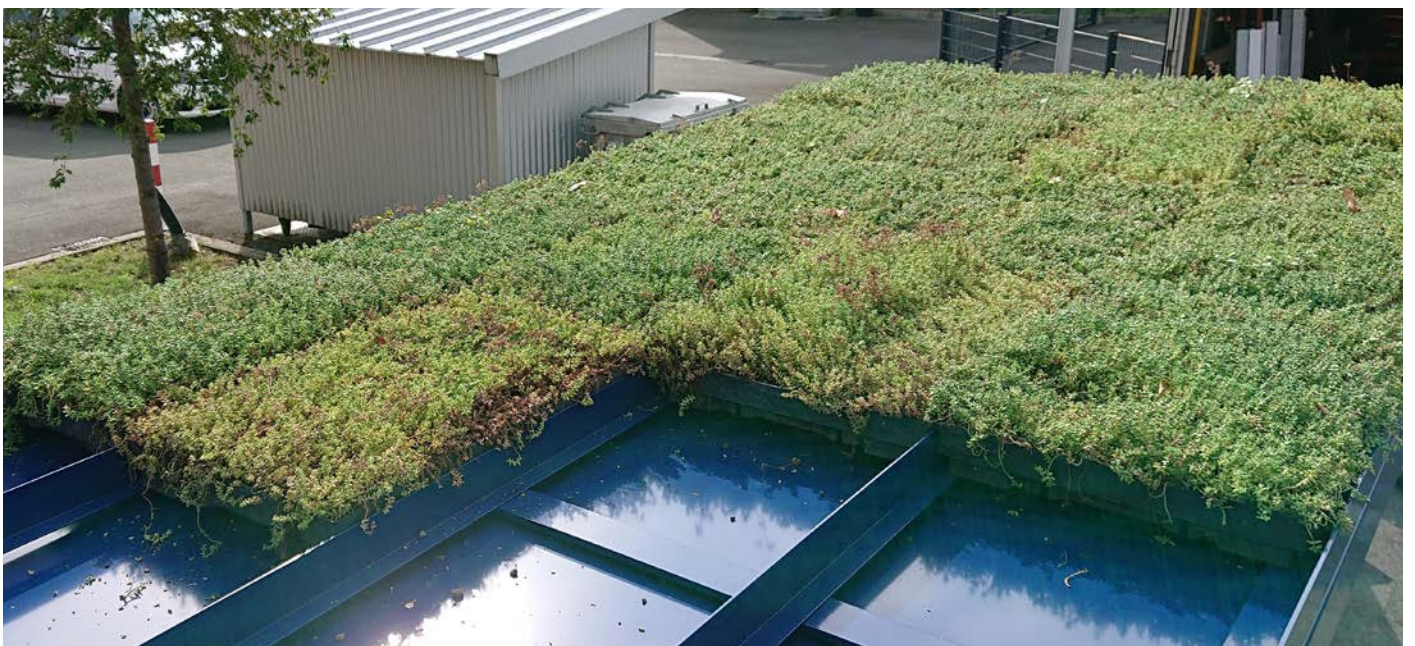
Das Dach der Wartehalle wird mit vorbegrüntem Kassetten bestückt
