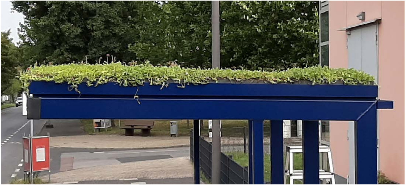
Seitenansicht Gründach Wartehalle A/G – Eindeckung des Gründachs bis zum Dachrand möglich
