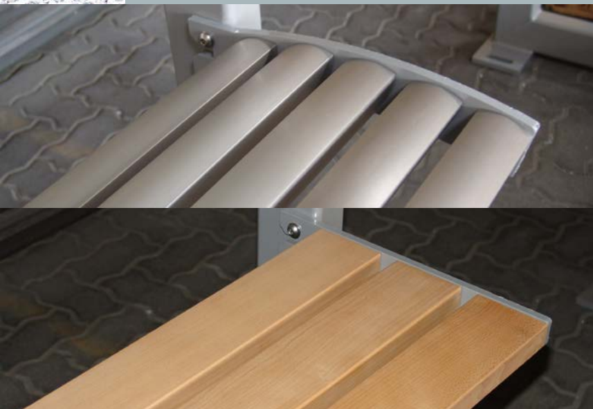
▲ Sitzbank an Stütze montiert (Alu eloxiert, Holzlattung)
