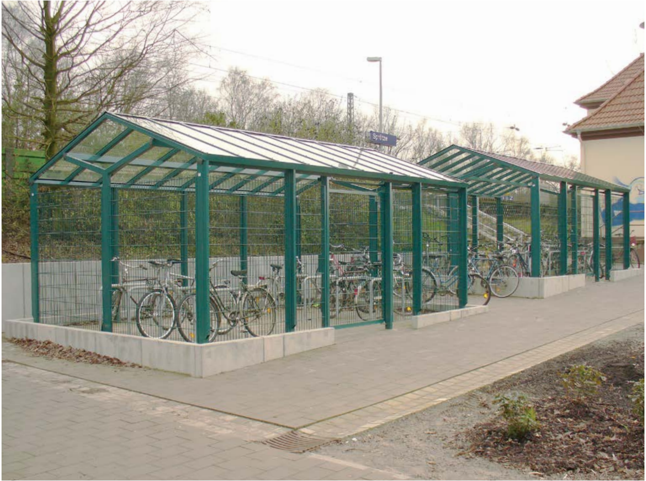
Fahrradabstellanlage M mit Stabgitterzaun und abschließbarer Schiebetür
