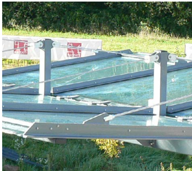
Detail der Dachkonstruktion Typ WH-OA1 ohne Gitterträger beim Stützenabstand vom 4,5 m und Bautiefe von 5 m
