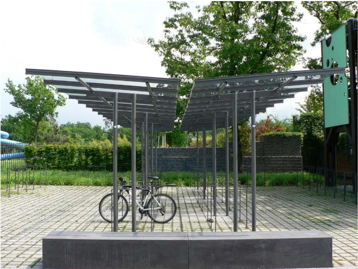
Filigrane Stahlkonstruktion aus Stahl-Rundrohr für die Fahrradüberdachung der Stadt Walldorf
