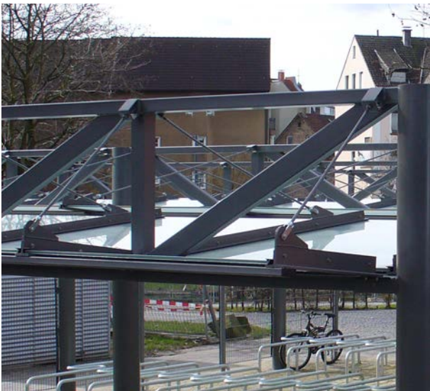
Detail der Dachkonstruktion mit Gitterträgern
