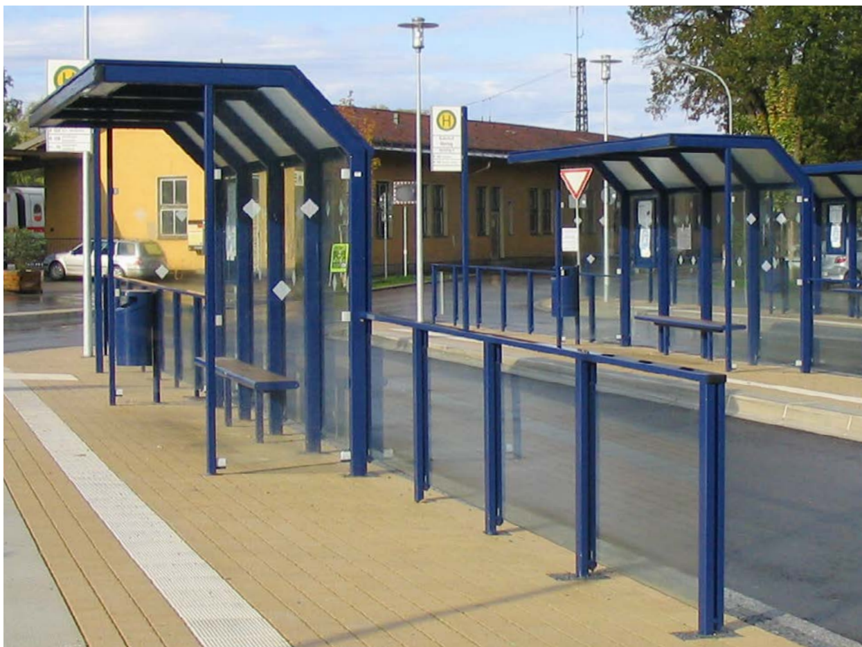
Wartehalle System A mit Spritzschutzwand am Bahnhof Mering
