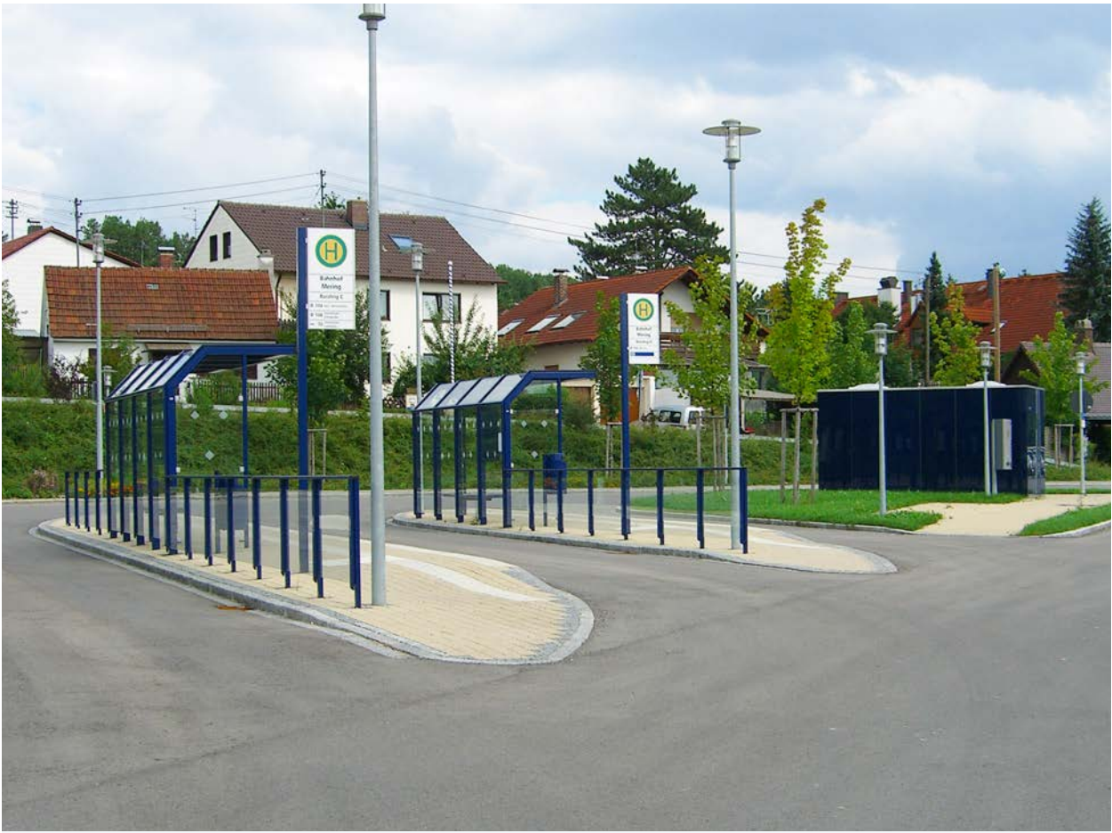
Wartehallen System A mit Spritzschutzwand am Bahnhof Mering
