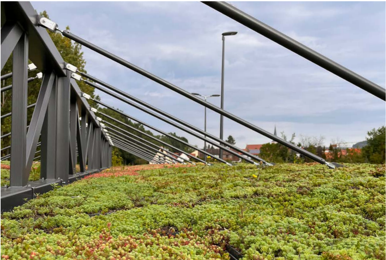
Dacheindeckung mit begrünten Pflanzkassetten
