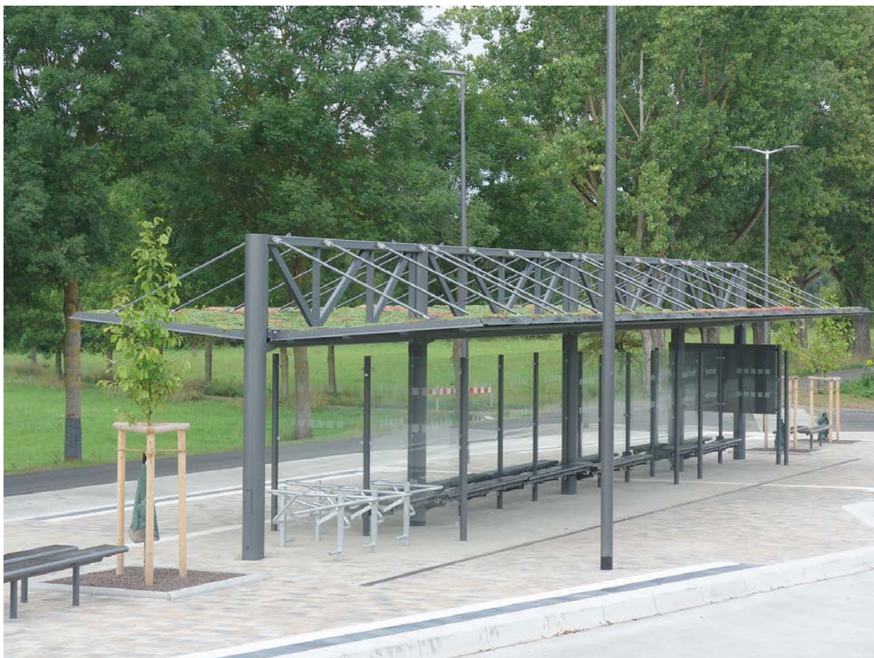
Überdachung System O doppelzeilig mit Gründach am ZOB Hammelburg
