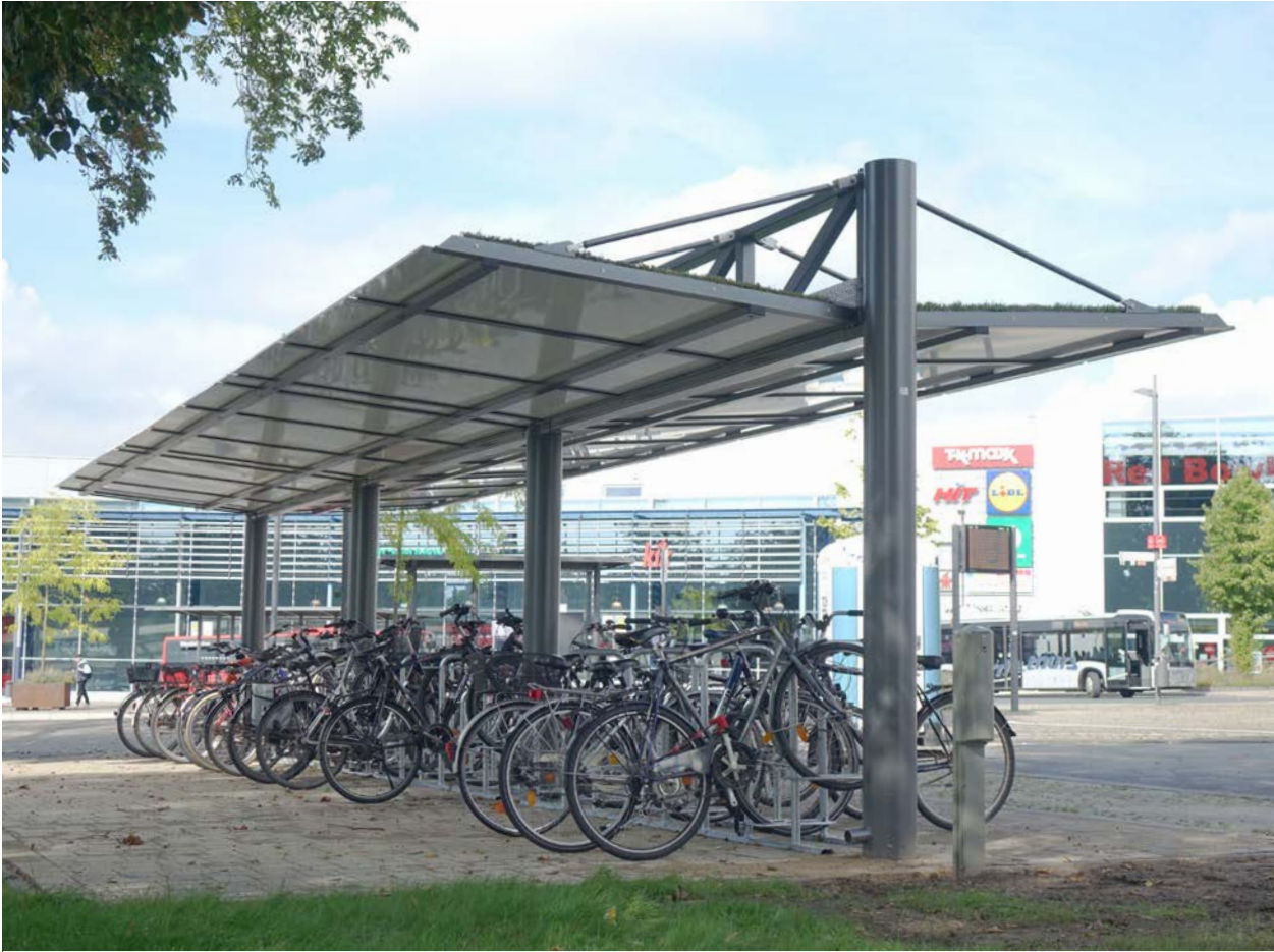
Fahrradüberdachung System O doppelzeilig am Bahnhof Soest mit Gründach
