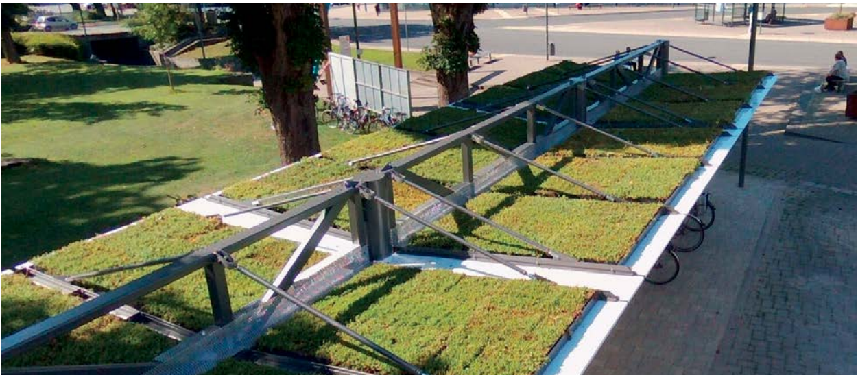
Fahrradüberdachung System O-G doppelzeilig für 80 Fahrräder am Bahnhof Soest
