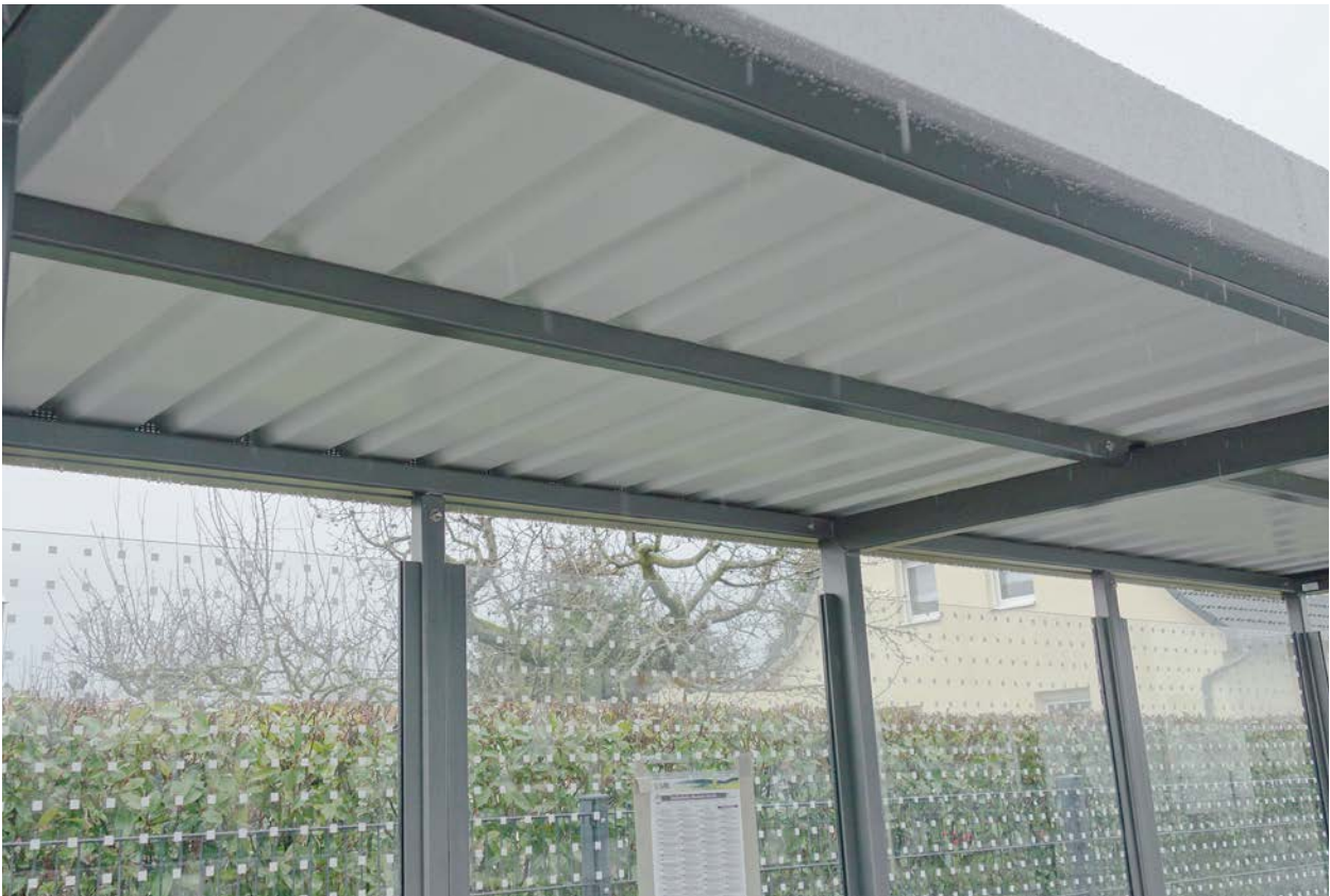
Unterzug der Dachkonstruktion beim Gründach der Wartehalle D-G
