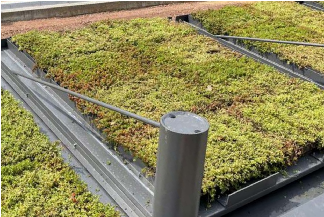
vorbegrünte Dachkassetten auf der Wartehalle System O
