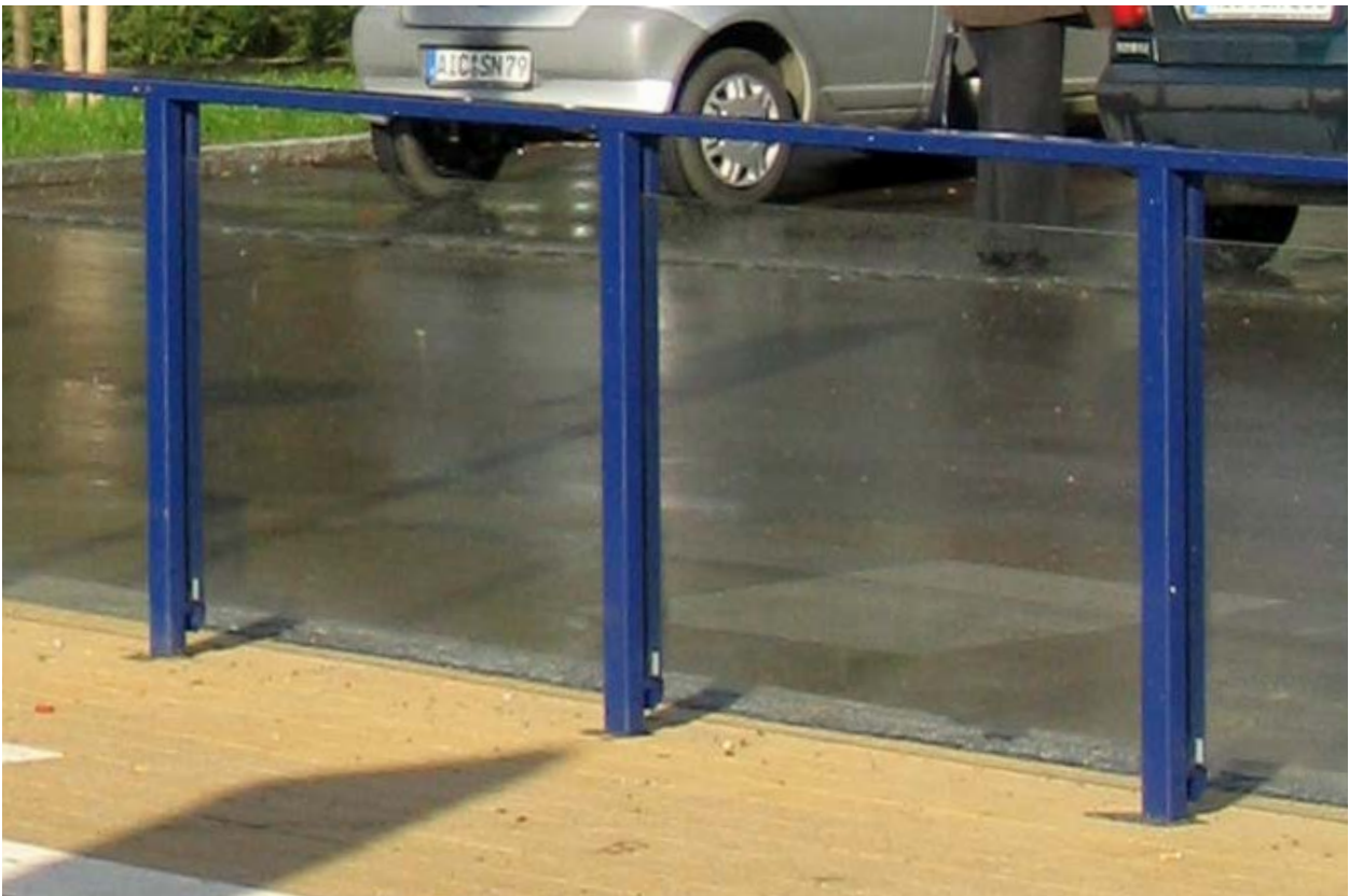
Spritzschutzwand mit Handlauf und linearer Verglasung
