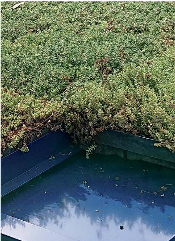
Wartehallendach mit vorbegrüntem Pflanzkassetten
