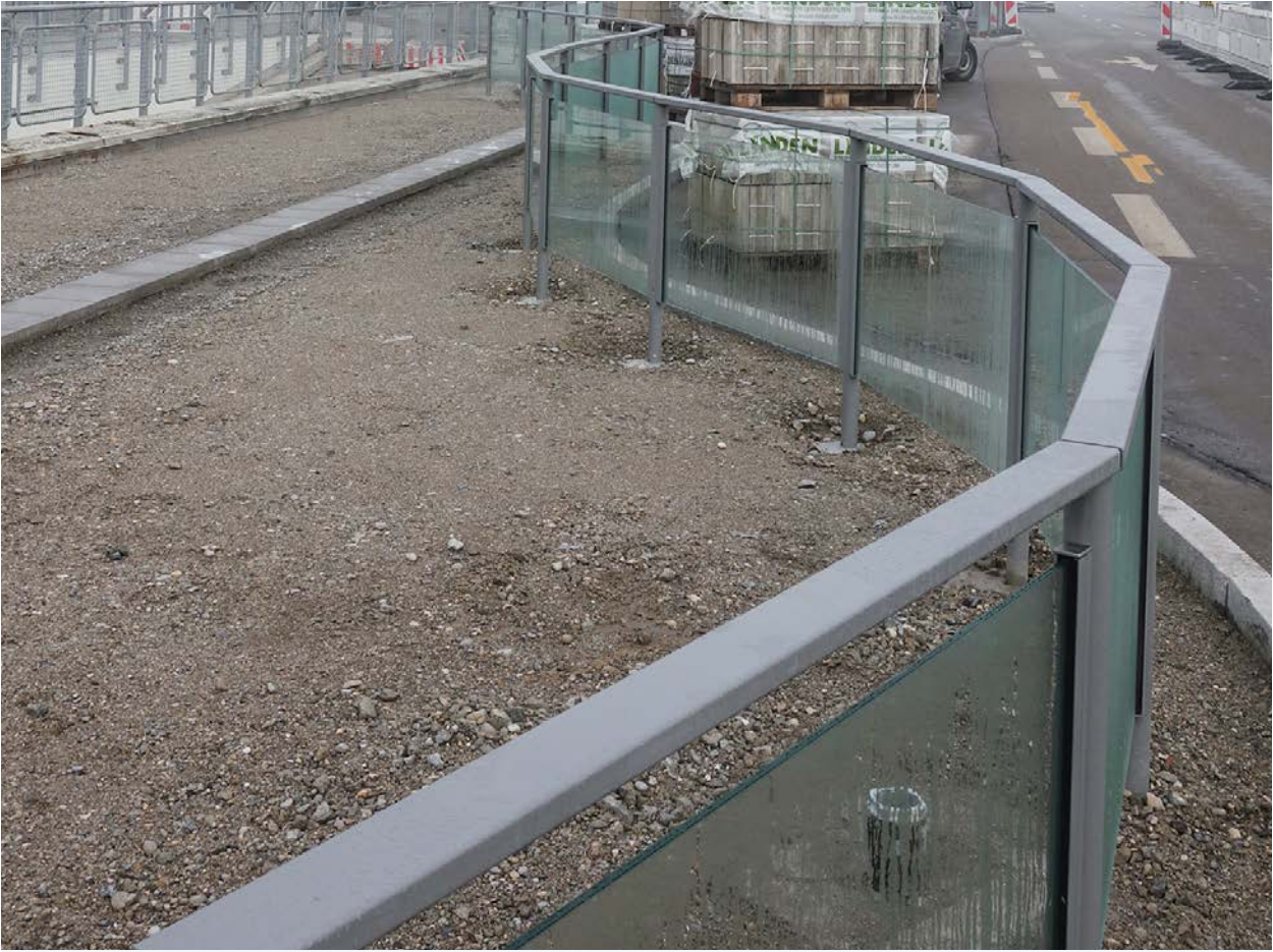
polygone Aufstellung der Spritzschutzwand BASIC
