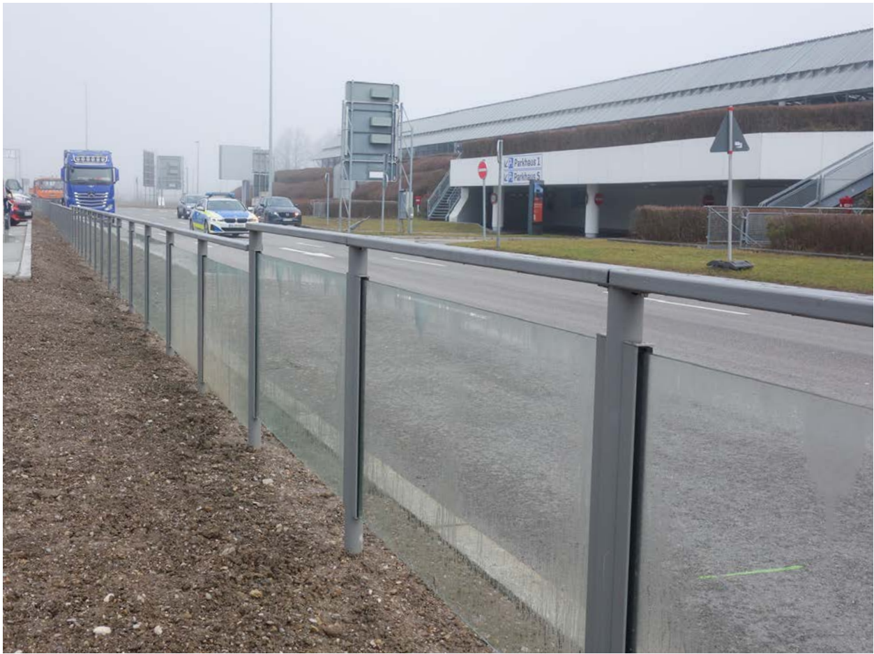
Spritzschutzwand BASIC in linearer Aufstellung mit Gefälleanpassung
